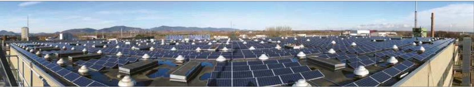
Die erste größere Anlage in Landau liefert seit 2011 jährlich etwa 520.000 kWh PV-Strom ins Netz.
